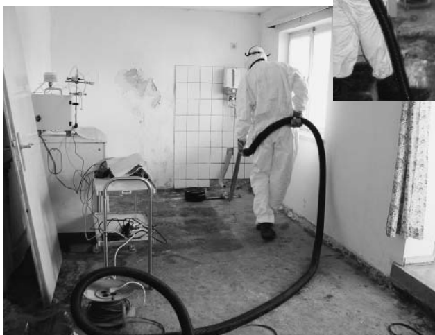
Mikrobiologische Feinreinigung mit Sicherheitssauger.
