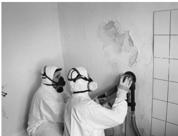
Sporen- und staubfreie Abtragung von mit Schimmelpilz befallenem Putz.
